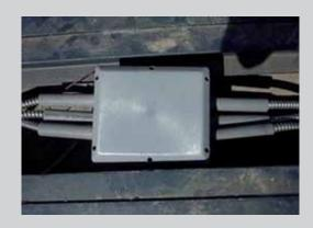
**Konstruktion**: Messing vernickelte Verschraubungen, bestehend aus 2 Teilen (Gehäuse und Hülse).
