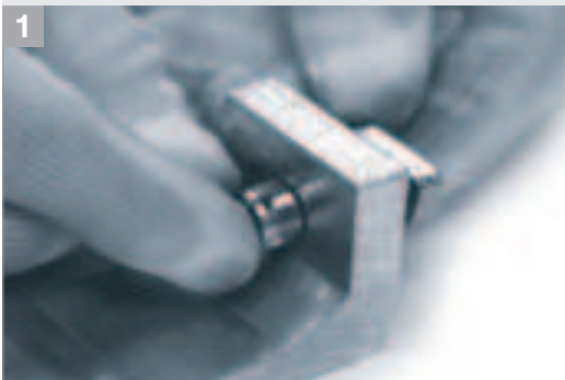
1 Montagewinkel und Schraubenset vormontieren 2 Montagesets Heavy Duty außen zu befestigen. Bitte darauf achten, dass die Montagesets zur Hälfte aus der Rinne herausragen
