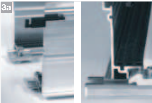
Montagesets Basic innen 3a oder außen 3b befestigen (Prüfen ob die Festigkeit der Befestigung ausreichend ist). Darauf achten, dass die Montagesets und Verbinder zur Hälfte aus der Rinne herausragen und die Gleitmutter richtig in das C-Profil eingesetzt wird
